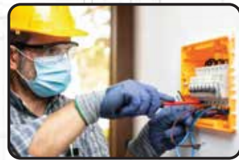
Kerja Pendawaian Elektrik
